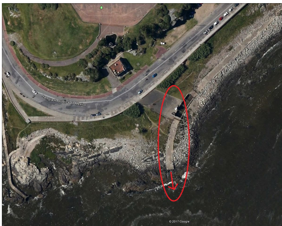
Figura 5.1. Vertedero en la zona de Punta Gorda
