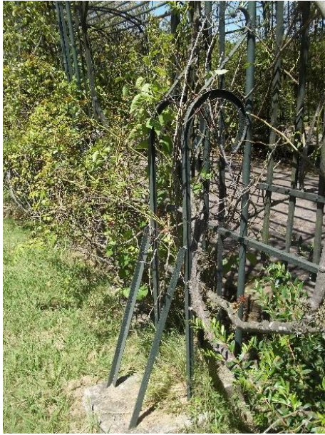
Fotografías 5.43 y 5.44: Contrafuertes laterales de la estructura metálica.
