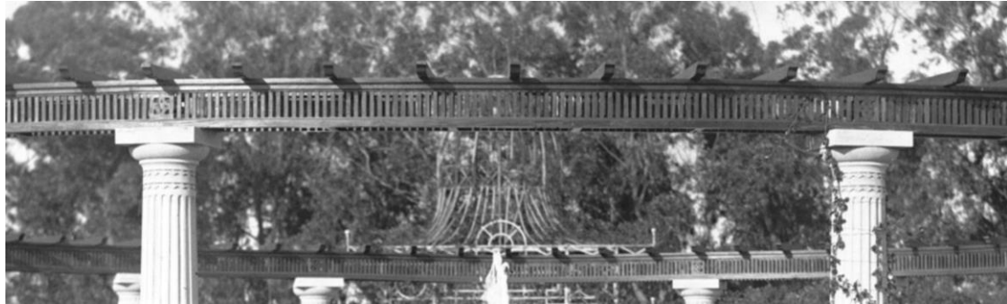
Fotografía 6.6: Detalle de fotografía. Recubrimiento lateral de perfiles de pérgola central. (s/d - CdF).
