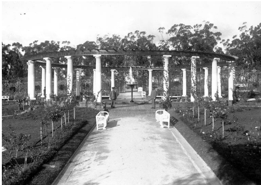
Fotografía 1.3: Año 1919 (2453FMH - CdF) – El espacio central con la conformación actual de la pérgola sobre las columnas dóricas y la fuente central.
