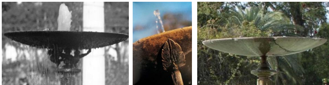
Fotografías 6.11 a 6.13: Detalles de apoyo del plato ornamental de La Rosaleda. A la izquierda, figuras escultóricas (detalle de fotografía de la década de 1920); al centro, fotografía del año 1995 con otro tipo de apoyo (fotografía gentileza de Ramiro Rodríguez Barilari); a la derecha, fotografía c. 2012 (s/d).
