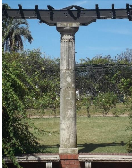
Fotografías 6.5: Columna de mampostería.
