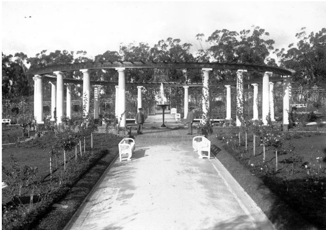
Fotografía 5.45: Año 1919– El espacio central con la conformación actual de la pérgola sobre las columnas dóricas y la fuente central. (2453FMH - CdF).
