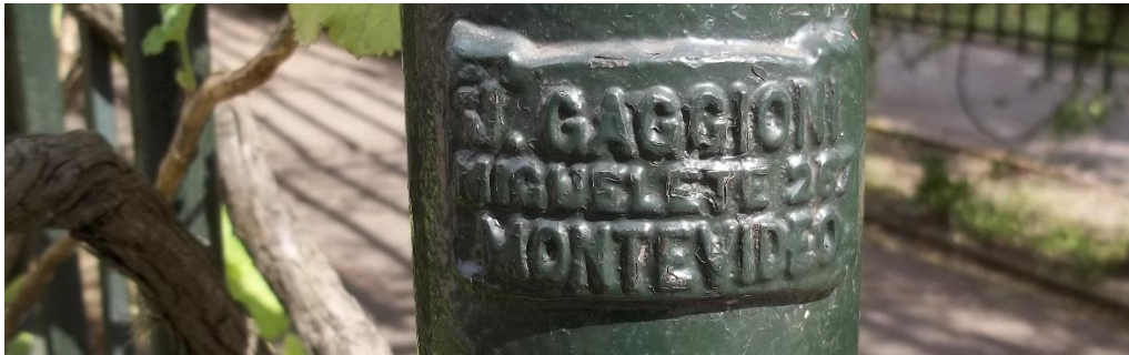
Fotografía 5.24: J. Gaggioni. Miguelete 267. Montevideo – Sello estampado en la estructura metálica de la rosaleta
