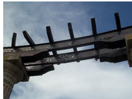
Fotografías 6.7 y 6.8: Detalle del estado sectores de piezas de madera sobre los perfiles metálicos.
