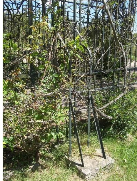
Fotografías 5.43 y 5.44: Contrafuertes laterales de la estructura metálica.
