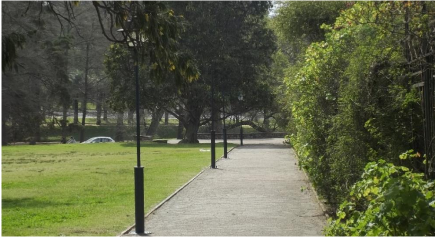
Fotografía 6.14: Columnas con luminarias faltantes.
