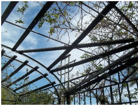
Fotografías 6.3 y 6.4: Detalle del estado de sectores de listones de madera sobre las pérgolas metálicas.
