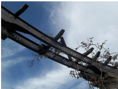
Fotografías 6.7 y 6.8: Detalle del estado sectores de piezas de madera sobre los perfiles metálicos.
