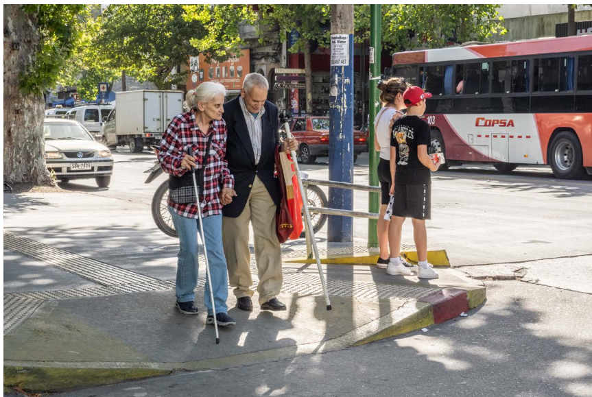
Avance de obras en veredas de Av. 8 de octubre, año 2024.
