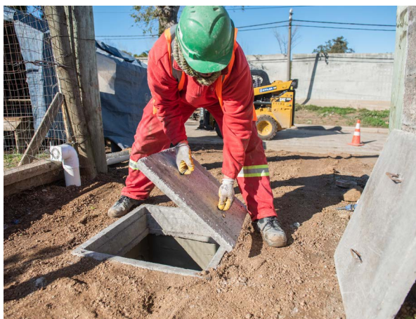
Instalaciones de cámaras n.º 1 para la conexión a la red de saneamiento en Manga, año 2022.
