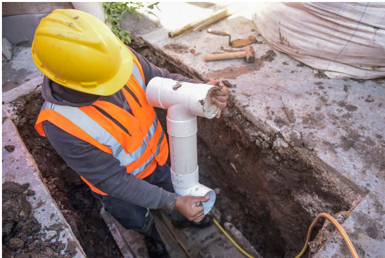
Construcción de cámaras n.º 1 en el barrio Casabó, año 2023.
