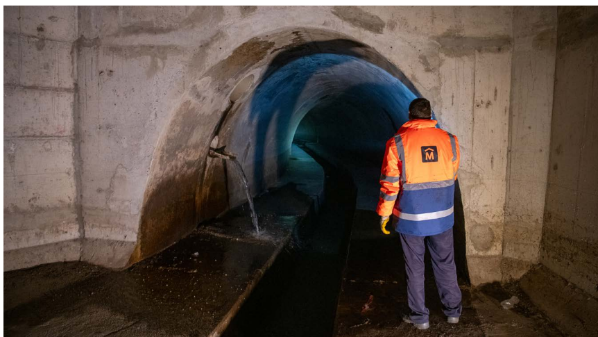
Finalización de obras en el arroyo Mataperros, año 2024.
