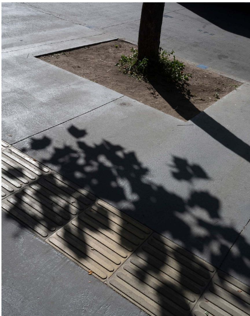
Avance de obras en veredas de Av. 8 de Octubre, año 2024.
