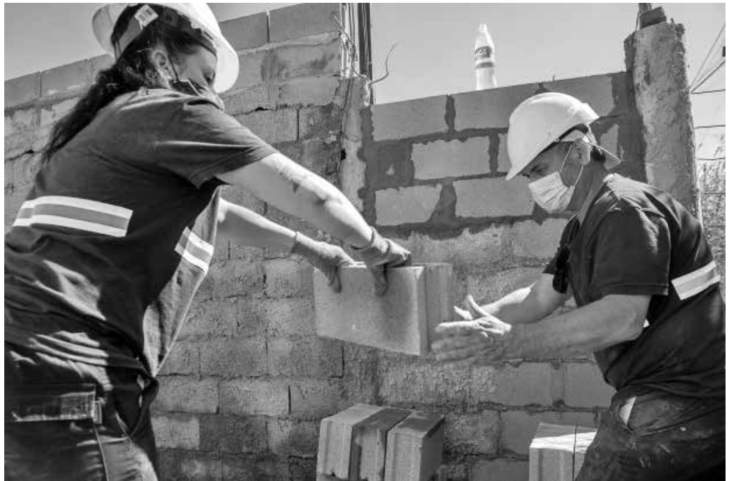
Refacción de vivienda en el marco del convenio IM DINALI, de 17 de setiembre 2021: Foto IM
