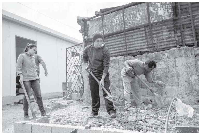
Obras de reparación en infraestructura de ollas populares, autor: Verónica Caballero
