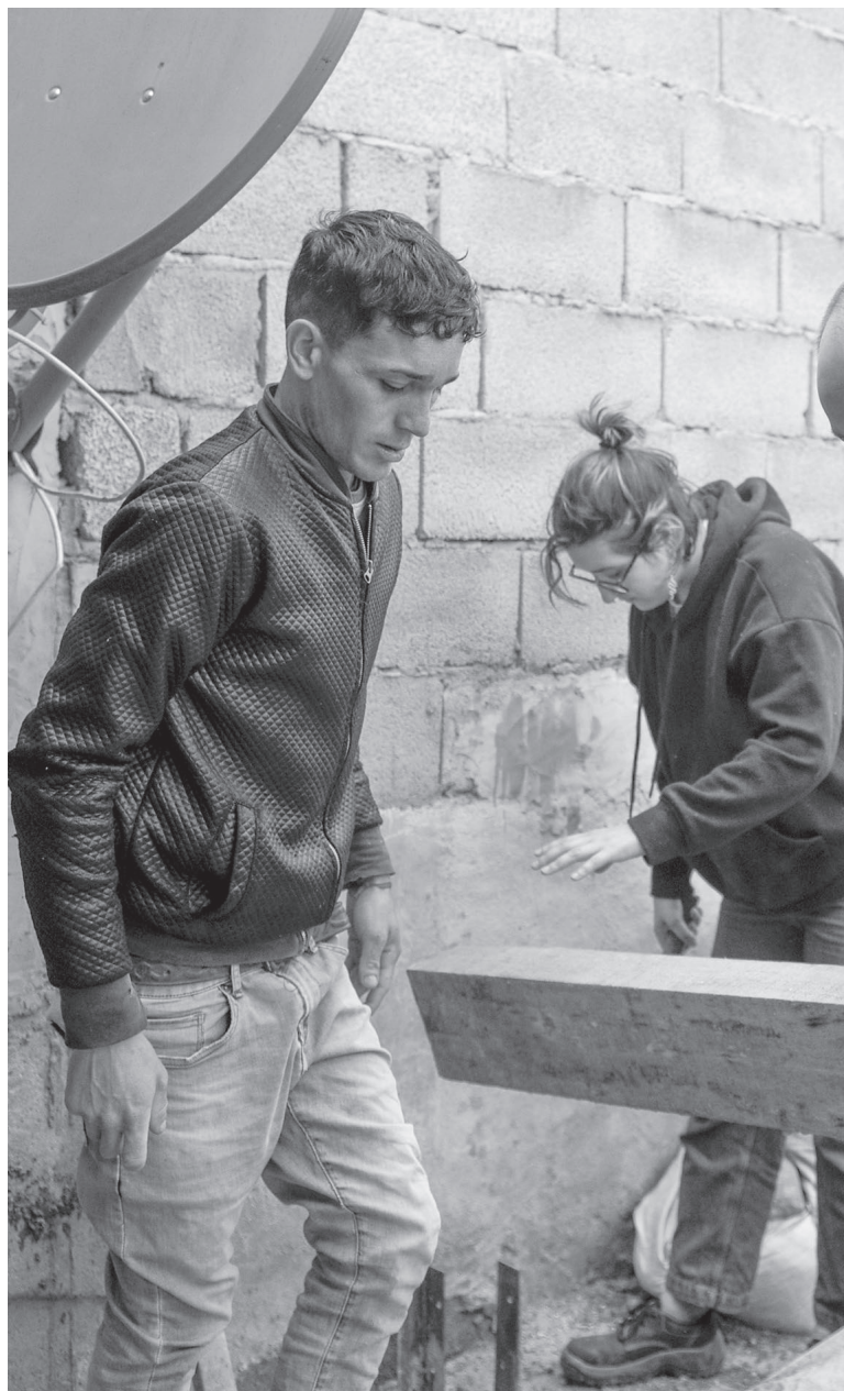
Obras de reparación en infraestructura de ollas populares, autor: Verónica Caballero
