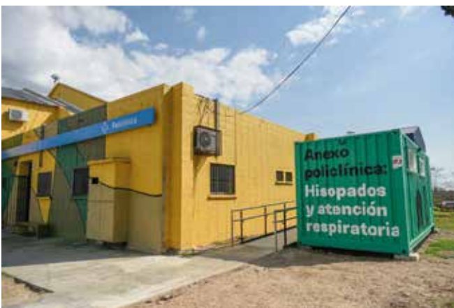
Instalación de contenedores en Policlínica Los Ángeles, 31 de agosto de 2021. Foto: Verónica Caballero/ IM
