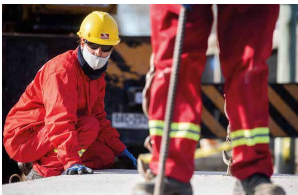
Montaje de dovelas en el barrio 24 de junio en el marco del Plan ABC, 30 de julio. Foto:Santiago Mazzarovich /IM
