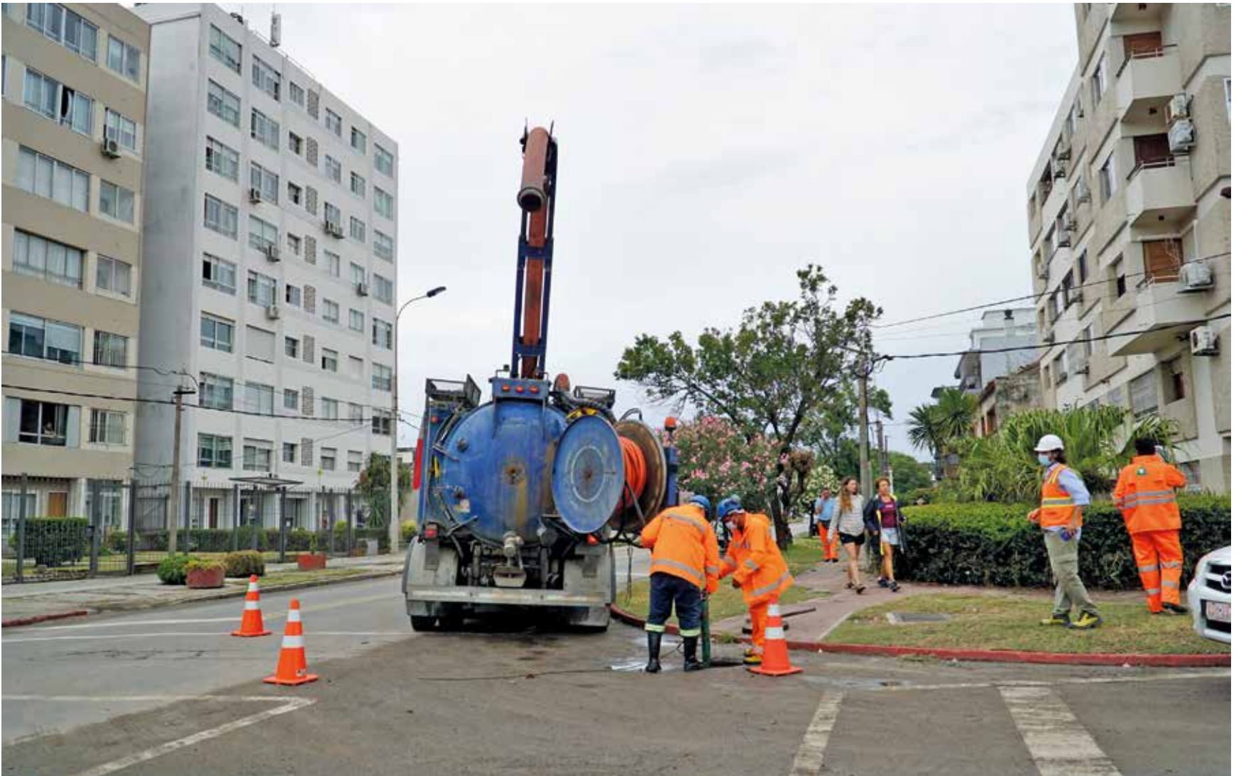
Cuadrillas de la Intendencia de Montevideo realizan tareas en barrio Malvín ante las intensas lluvias, 17 de enero de 2022. Foto: Verónica Caballero/ IM
