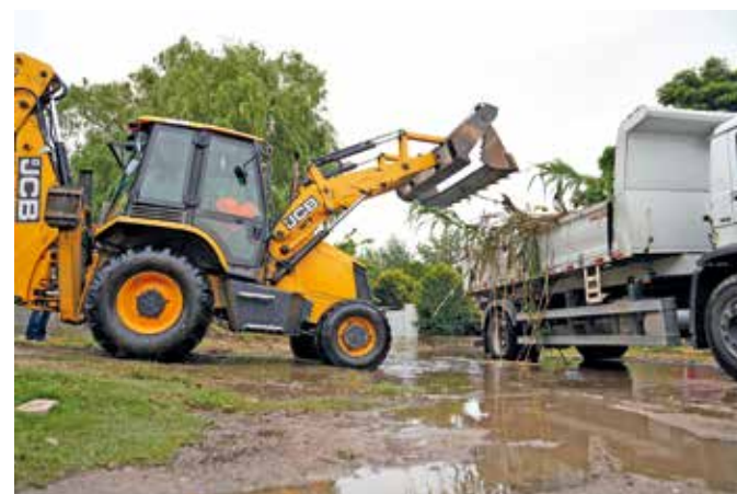
Tareas de desagüe tras la inundación en el Barrio Ideal, 18 DE ENERO DE 2022. Foto: Agustín Fernández Gabard / IM
