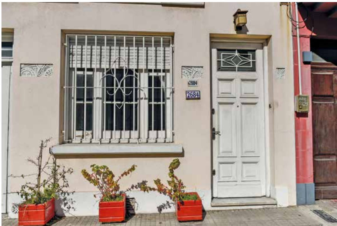
Refacción de fachadas, 27 de agosto de 2021. Foto: Verónica Caballero/ IM
