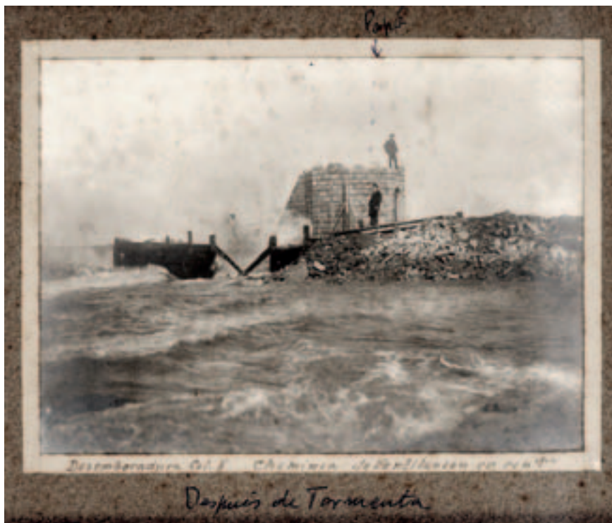
Desembocadura del colector II y chimenea de ventilación en construcción. Al centro: Ernesto Katzenstein (padre). Intersección de las calles Guaraní y Costa Sur. Años 1903-1906 (aprox.). (Foto: 030FPEK.CDFIMO.UY - Autor: S.d. - Donación: Ernesto Katzenstein [hijo]).
