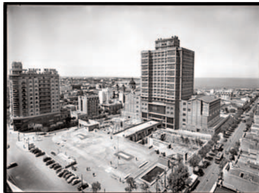
Construcción del atrio del Palacio Municipal. A la izquierda: Avenida 18 de Julio. A la derecha: calle Ejido. Año 1947. (Foto: 1619FMHB.CDFIMO.UY - Autor: S.d./IMO).
