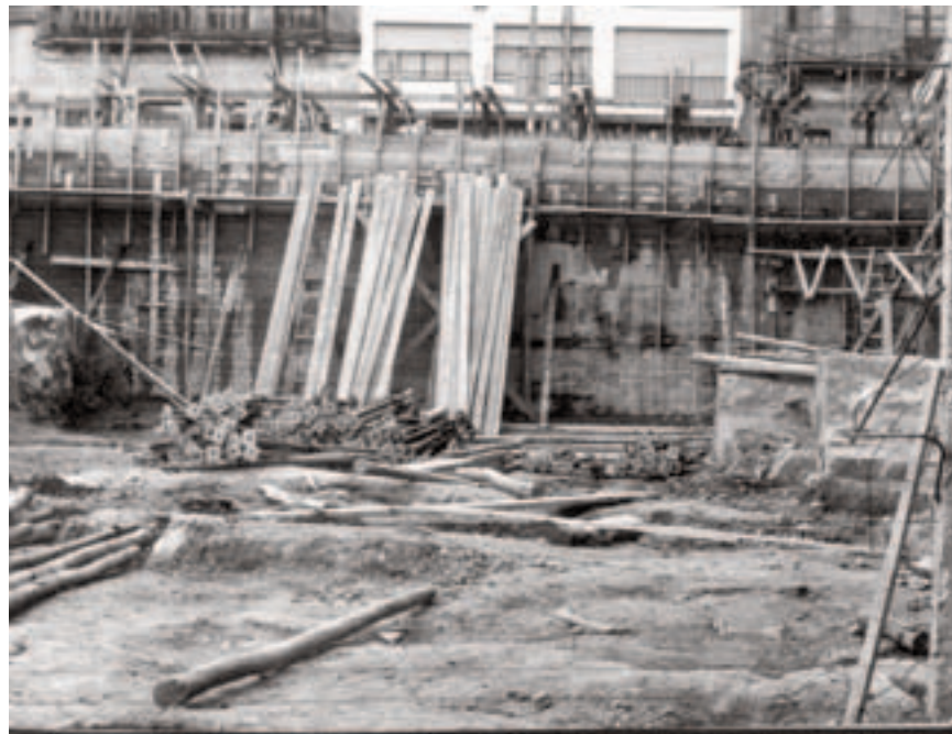
Construcción de la sede de AEBU. Años 1966-1971.
