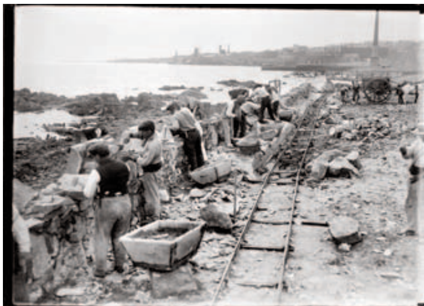
Construcción del muro de contención de la Rambla Sur. Al fondo: caño de saneamiento de la calle Paraguay. Años 1923-1926 (aprox.). (Foto: 18607FMHGE.CDFIMO.UY - Autor: S.d./IMO).
