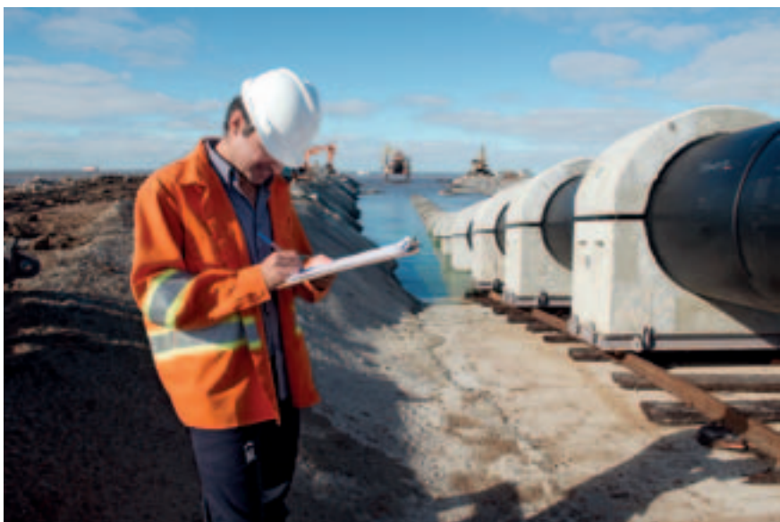
Pablo Morras. Obras de saneamiento en Punta Yeguas. 7 de marzo de 2016. (Foto: 58707FMCMA.CDF.IMO.UY - Autor: Carlos Contrera/CdF).
