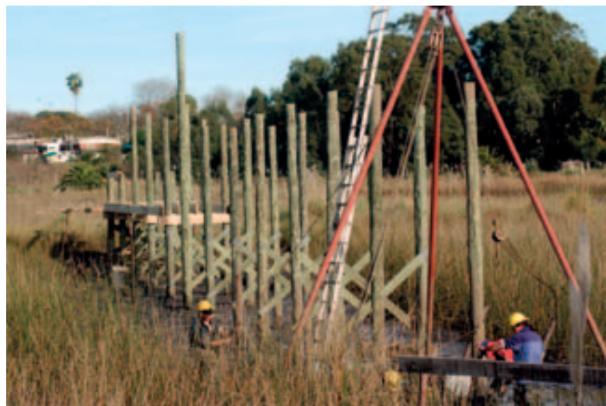
Conector del Humedal del río Santa Lucía en construcción. 8 de julio de 2005. (Foto: 036FMCPNSV.CDEIMO.UY - Autor: Carlos Contrera/CdF).
