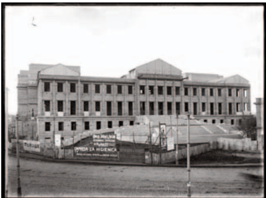
Frente principal del Palacio Legislativo durante su construcción. Año 1913 (aprox.). (Foto: 0047FMHACDFIMO.UY - Autor: S.d./IMO).
