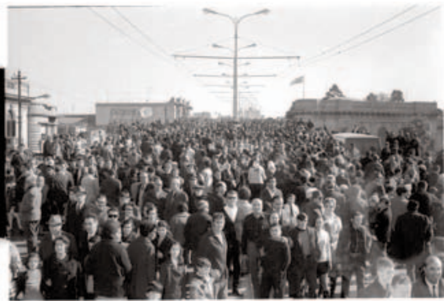
Inauguración del Viaducto del Paso Molino. 11 de junio de 1970. (Foto: 0310_22FMPCDFIMO.UY - Autor: S.d./IMO).
