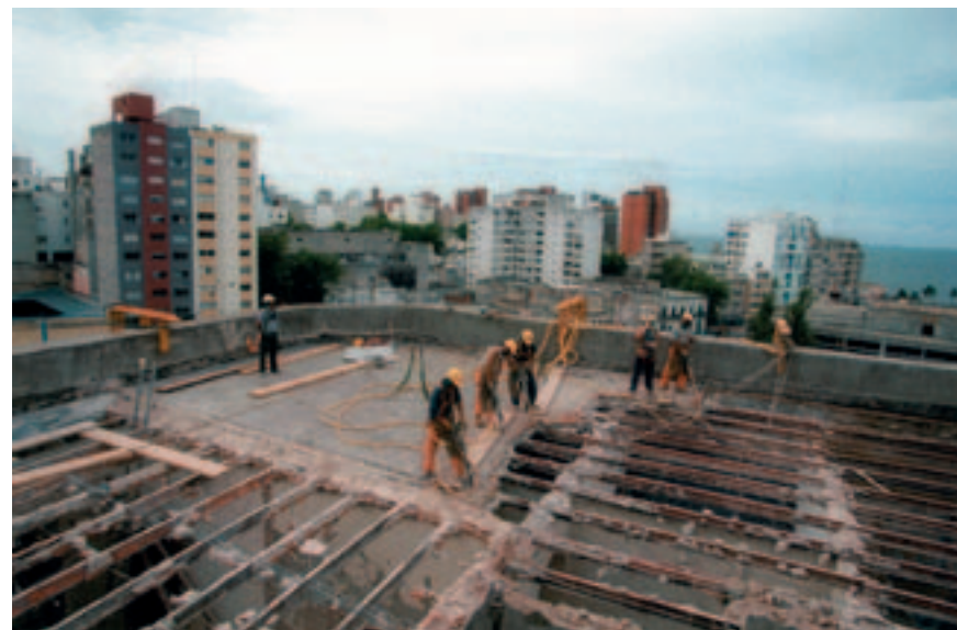
Demolición del techo de las naves laterales del Teatro Solís. S.f. (Foto: 0006FMCAS.CDF.IMO.UY - Autor: Carlos Contrera/CdF).
