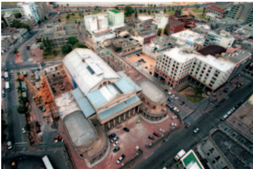
Teatro Solís en obra. Mayo de 2003. (Foto: 0024FMCAS.CDF.IMO.UY - Autor: Carlos Contrera/CdF).
