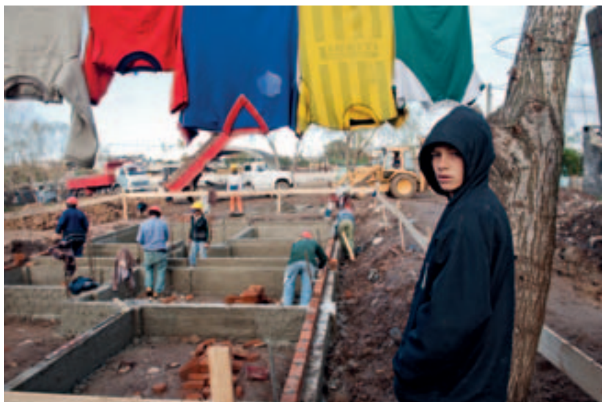
S.i. Obras de regularización del barrio 6 de Diciembre. 21 de junio de 2011. (Foto: 40095FMCMA.CDF.IMO.UY - Autor: Carlos Contrera/CdF).
