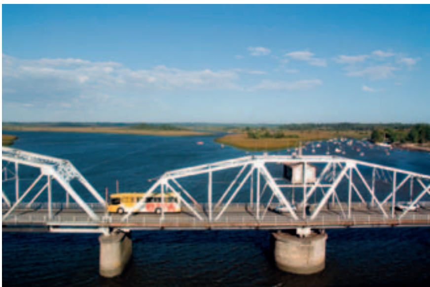
Puente sobre el río Santa Lucía. 13 de diciembre de 2005. (Foto: 196FMCPNSV.CDEIMO.UY - Autor: Carlos Contrera/CdF).
