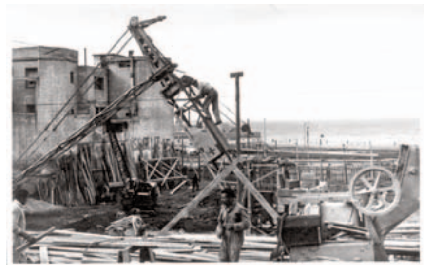
Construcción de la sede de AEBU. Años 1966-1967.
