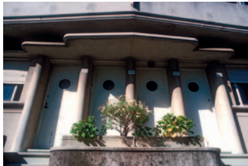
Conjunto de Viviendas en Barrio Jardín. Calle 21 de setiembre del 2341 al 2347 y del 2373 al 2379. Año 2003. (Foto: 020FMCAAD.CDFIMO.UY - Autor: Martín Atme/CdF).
