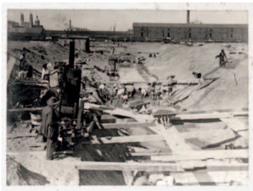
Construcción del vertedero de la calle Nueva York. Al fondo: Iglesia de la Aguada e instalaciones de la Estación Central del Ferrocarril. Años 1906-1907 (aprox.) (Foto: 002FPEK.CDFIMO.UY - Autor: S.d. - Donación: Ernesto Katzenstein [hijo]).
