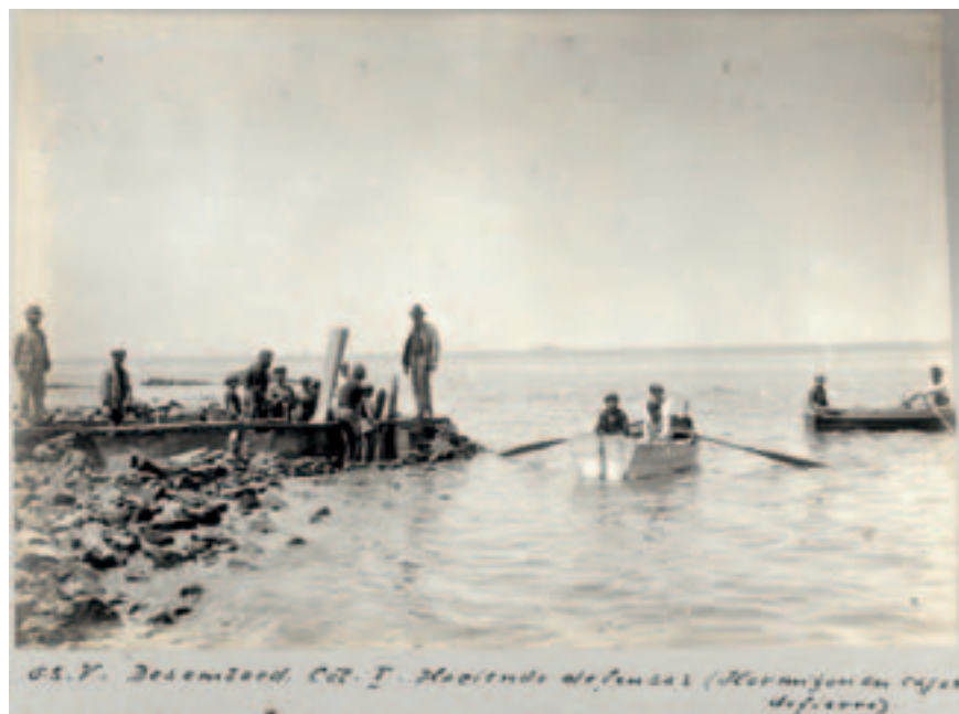
Construcción del colector I del saneamiento del Puerto de Montevideo a la altura de su desembocadura. Años 1903-1907 (aprox.). (Foto: 058FPEK.CDFIMO.UY - Autor: S.d. - Donación: Ernesto Katzenstein [hijo]).
