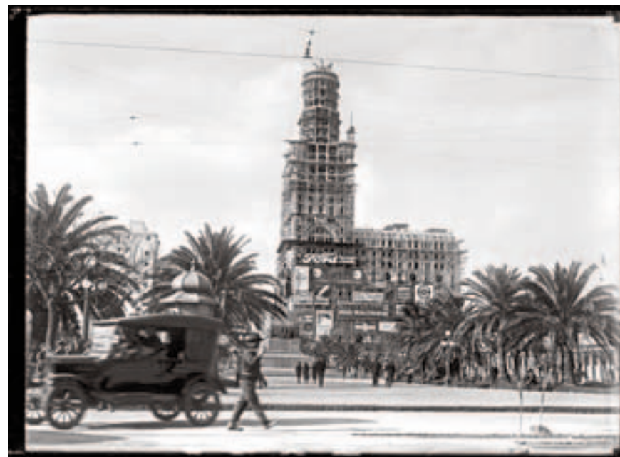
Palacio Salvo durante su construcción. Adelante: Plaza Independencia. Año 1925. (Foto: 0684FMHB.CDFIMO.UY - Autor: S.d./IMO).
