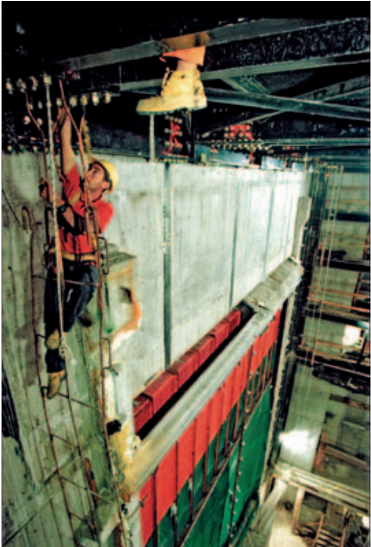
Construcción de la nueva caja escénica del Teatro Solís. Febrero de 2004. (Foto: 0015FMCAS.CDF.IMO.UY - Autor: Carlos Contrera/CdF).
