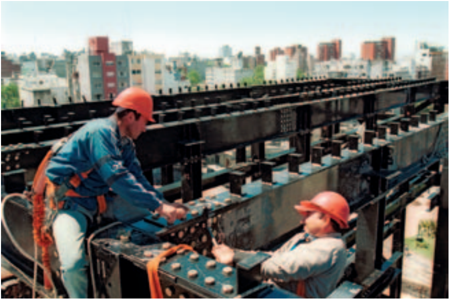
Construcción de la nueva caja escénica del Teatro Solís. Julio de 2003. (Foto: 0059FMCAS.CDF.IMO.UY - Autor: Carlos Contrera/CdF).
