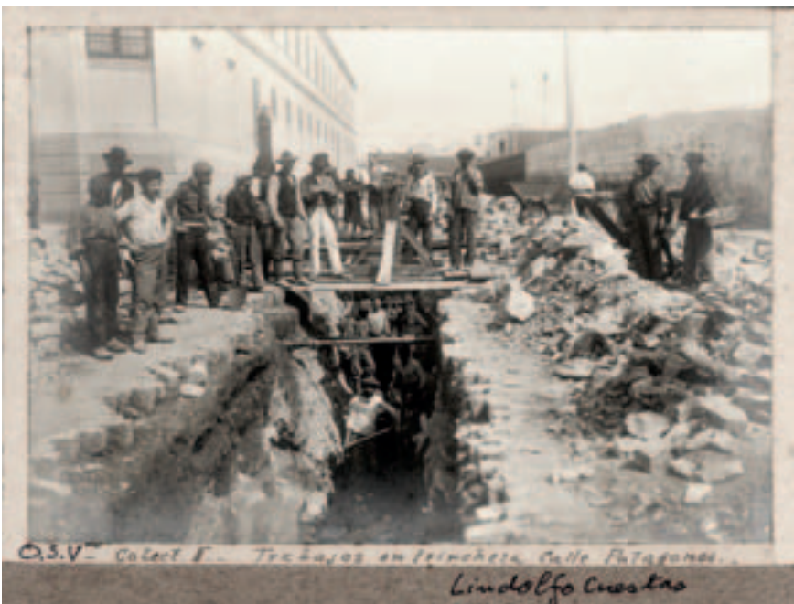
Construcción del colector II del saneamiento del Puerto de Montevideo. A la izquierda: edificio de la Aduana. Calle Juan Lindolfo Cuestas (ex Patagones). Años 1903-1906 (aprox.). (Foto: 045FPEK.CDFIMO.UY - Autor: S.d. - Donación: Ernesto Katzenstein [hijo]).
