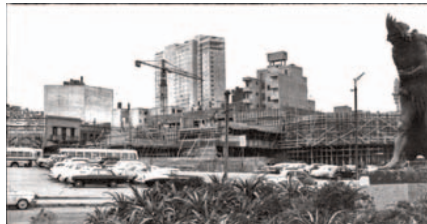
Construcción de la sede de AEBU. Años 1966-1967.
