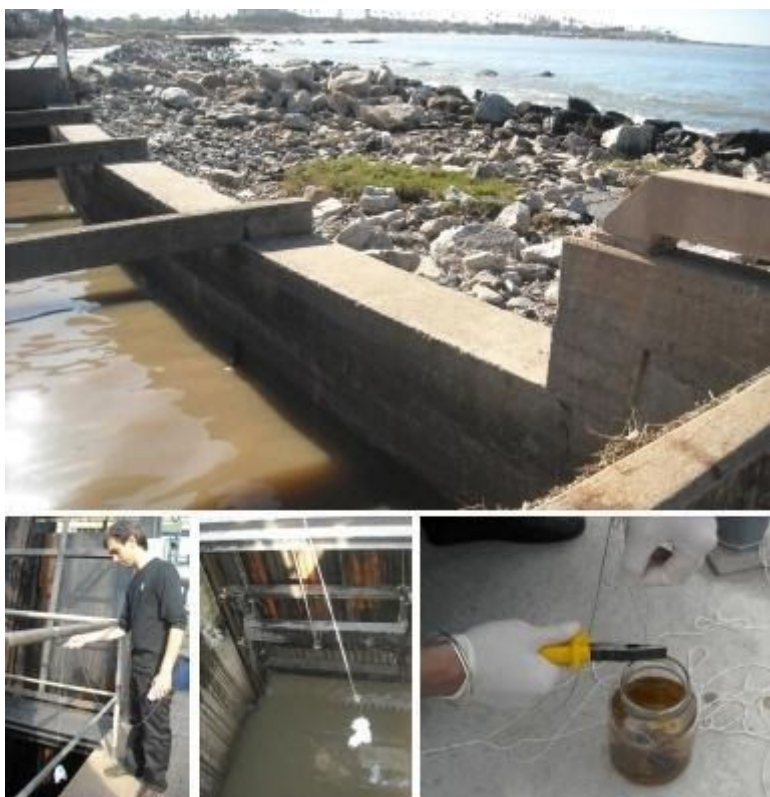
Figura 6.2. Colocación de y retiro de hisopo de Moore en aliviaderos del sistema de saneamiento.
