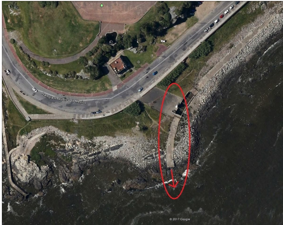
Figura 5.1. Vertedero en la zona de Punta Gorda
