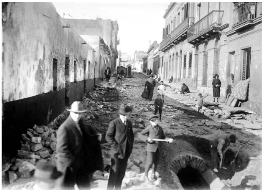
Figura 1.1 Obras de saneamiento en la calle Valles, en la Ciudad Vieja, circa 1920. Fuente: CMDF referencia 18625FMHGE.
