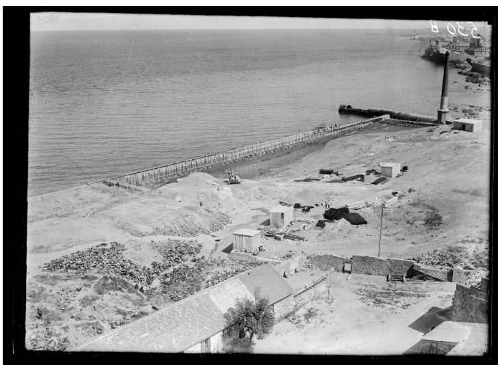
0530FMHB Construcción de la Rambla Sur vista desde la chimenea de la Usina Municipal. Barrio Sur.
