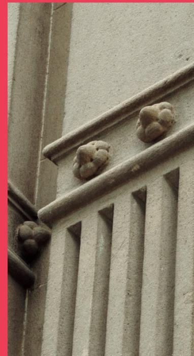
sión de los hierros que funcionan como anclaje o estructura de las piezas. Esta corrosión produce esfuerzos en el material de recubrimiento o revoque, generando en primera instancia microfisuras, luego el desplazamiento del material y finalmente su desprendimiento.
