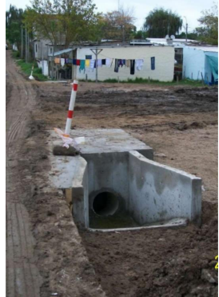
Tomas de cuneta
