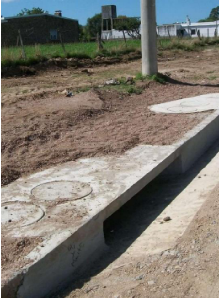
Bocas de tormenta
