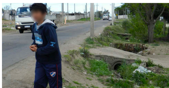
Fotografía 3: Sin sendas peatonales o veredas
