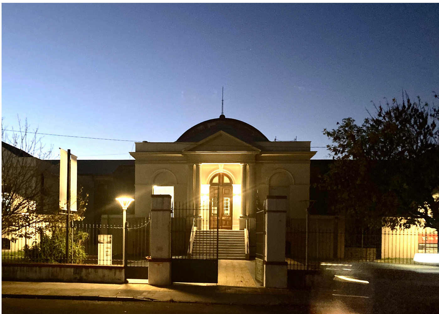
Antigua cárcel de Miguelete
