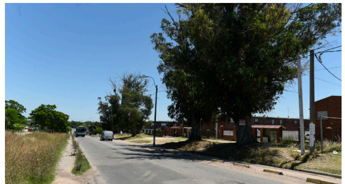
Fotografía 3: Estado de circulación frente a Barrio 3 de abril
