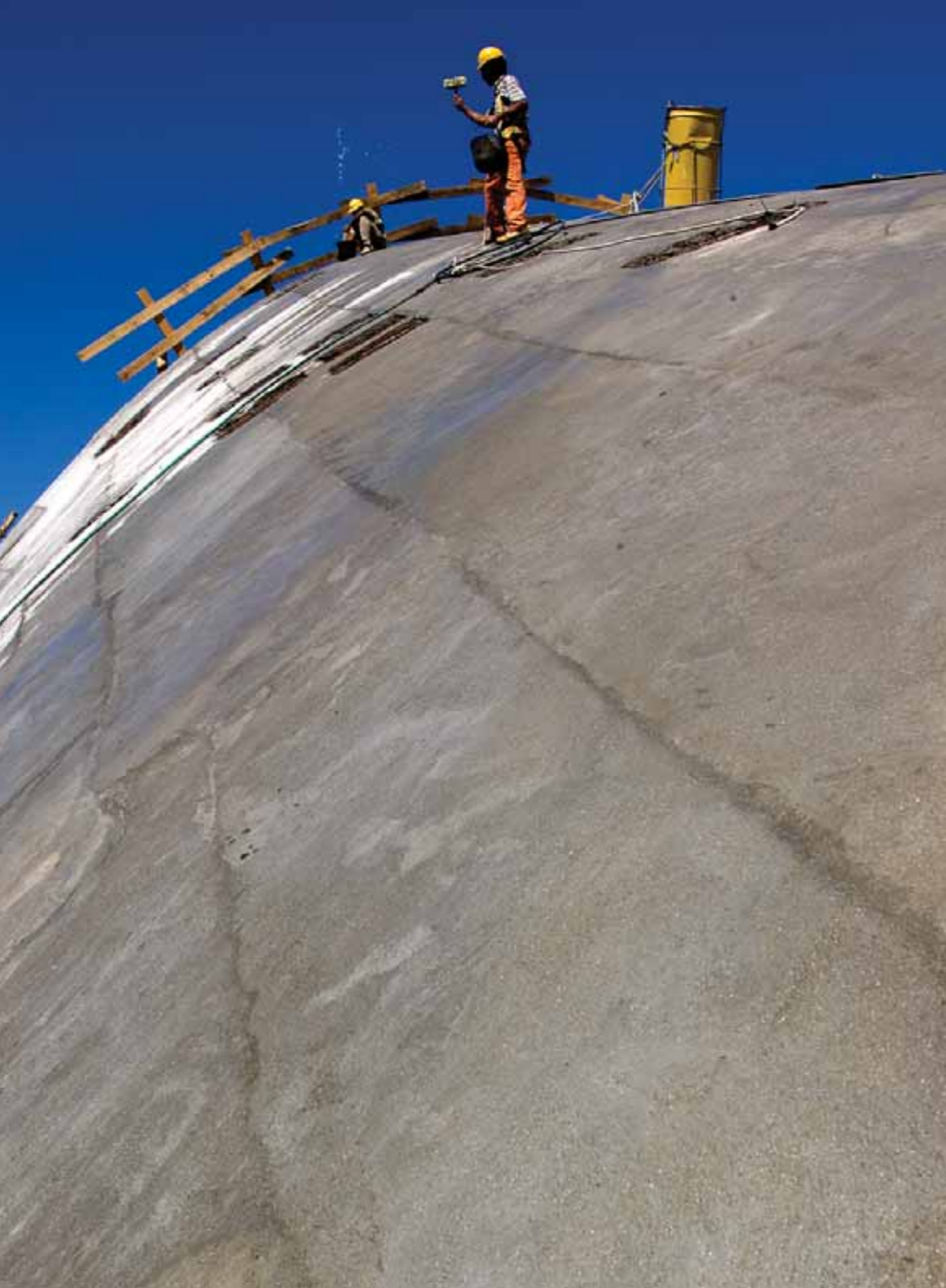
Obras de construcción de la nueva bóveda del Teatro de Verano "Ramón Collazo". 12 de diciembre de 2006. (Foto: 20070FMCMACMDF.IMM.UY - Autor: Carlos Contrera/CdF) Trabalhos de construção da nova abóbada do Teatro de Verão "Ramón Collazo". 12 de dezembro de 2006. (Foto: 20070FMCMACMDF.IMM.UY - Autor: Carlos Contrera/CdF) Building works of the new vault, Summer Theatre "Ramón Collazo". December 12, 2006. (Photo number: 20070FMCMACMDF.IMM.UY - Author: Carlos Contrera/CdF)
