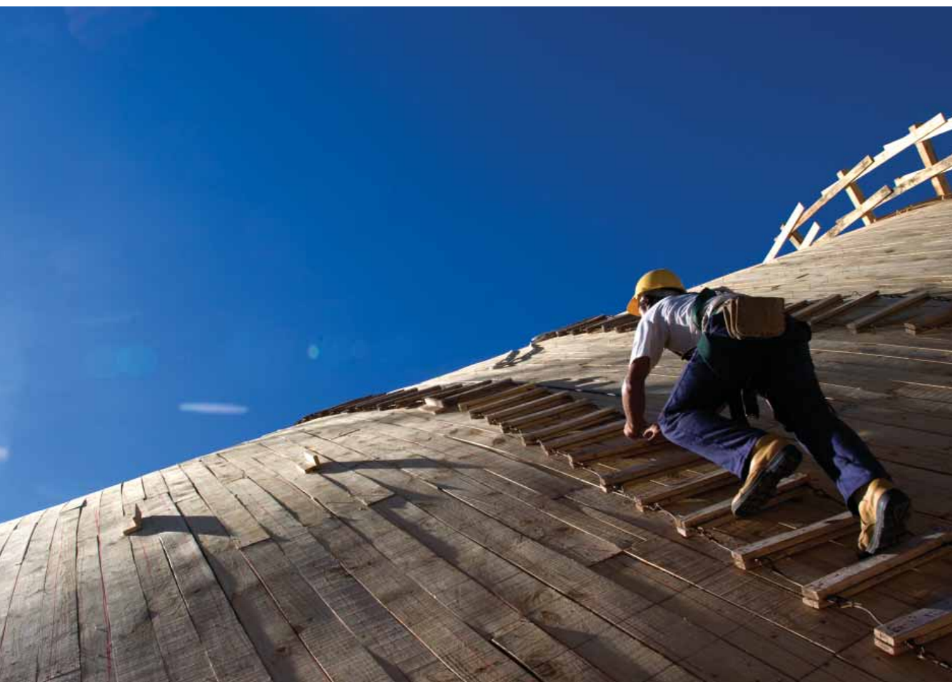
Obras de construcción de la nueva bóveda del Teatro de Verano "Ramón Collazo". 22 de noviembre de 2006. (Foto: 20043FMCMA.CMDF.IMM.UY - Autor: Carlos Contrera/CdF)
