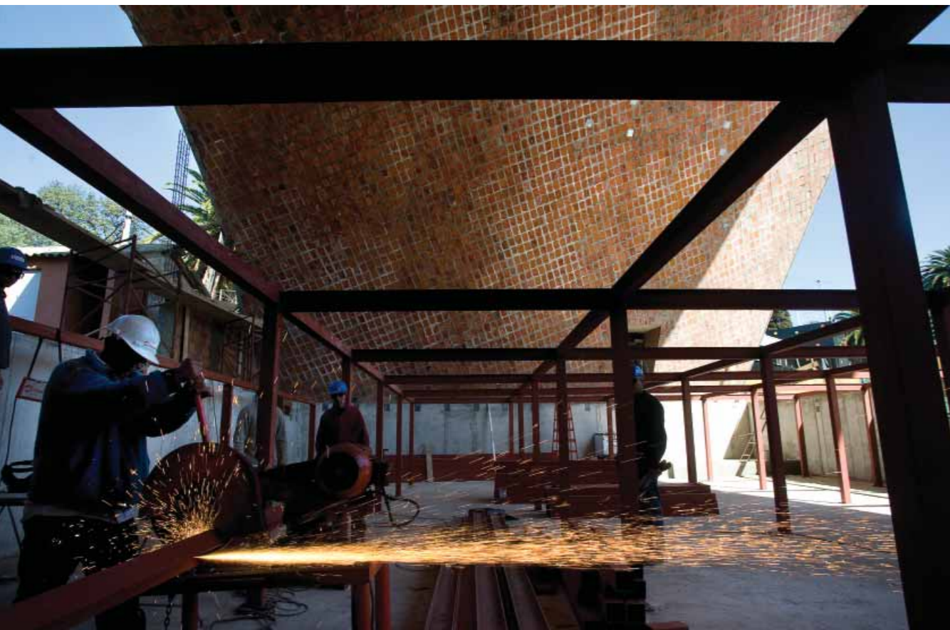
Obras de construcción del bajo escenario técnico del Teatro de Verano "Ramón Collazo". 7 de octubre de 2009. (Foto: 17886FMCMA.CMDF.IMM.UY - Autor: Carlos Contrera/CdF) Trabalhos de construção do espaço técnico no cenário do Teatro de Verão "Ramón Collazo". 7 de outubro de 2009. (Foto: 17886FMCMA.CMDF.IMM.UY - Autor: Carlos Contrera/CdF) Building works of the technical stage wing, Summer Theatre "Ramón Collazo". October 7, 2009. (Photo number: 17886FMCMA.CMDF.IMM.UY - Author: Carlos Contrera/CdF)
