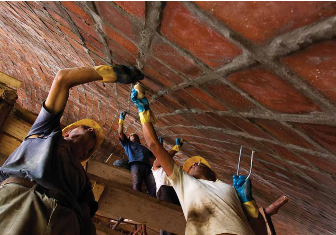
Obras de construcción de la nueva bóveda del Teatro de Verano "Ramón Collazo". 19 de diciembre de 2006. (Foto: 20085FMCMA.CMDF.IMM.UY - Autor: Carlos Contrera/CdF) Trabalhos de construção da nova abóbada do Teatro de Verão "Ramón Collazo". 19 de dezembro de 2006. (Foto: 20085FMCMA.CMDF.IMM.UY - Autor: Carlos Contrera/CdF) Building works of the new vault, Summer Theatre "Ramón Collazo". December 19, 2006. (Photo number: 20085FMCMA.CMDF.IMM.UY - Author: Carlos Contrera/CdF)
