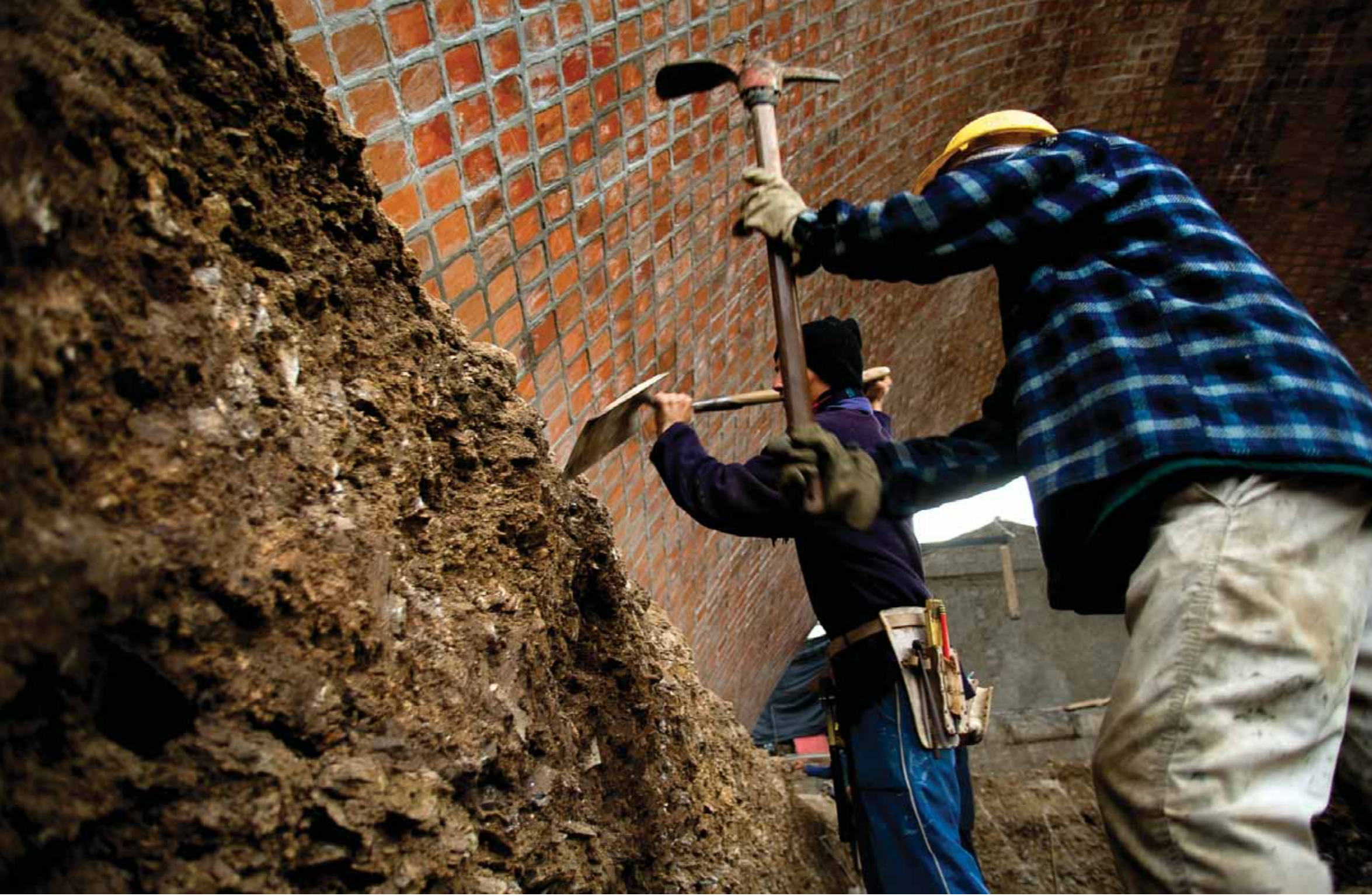
Obras de construcción del bajo escenario técnico del Teatro de Verano "Ramón Collazo". 28 de julio de 2009. (Foto: 17693FMCMA.CMDF.IMM.UY - Autor: Carlos Contrera/CdF) Trabalhos de construção do espaço técnico no cenário do Teatro de Verão "Ramón Collazo". 28 de julho de 2009. (Foto: 17693FMCMA.CMDF.IMM.UY - Autor: Carlos Contrera/CdF) Building works of the technical stage wing, Summer Theatre "Ramón Collazo". July 28, 2009. (Photo number: 17693FMCMA.CMDF.IMM.UY - Author: Carlos Contrera/CdF)
