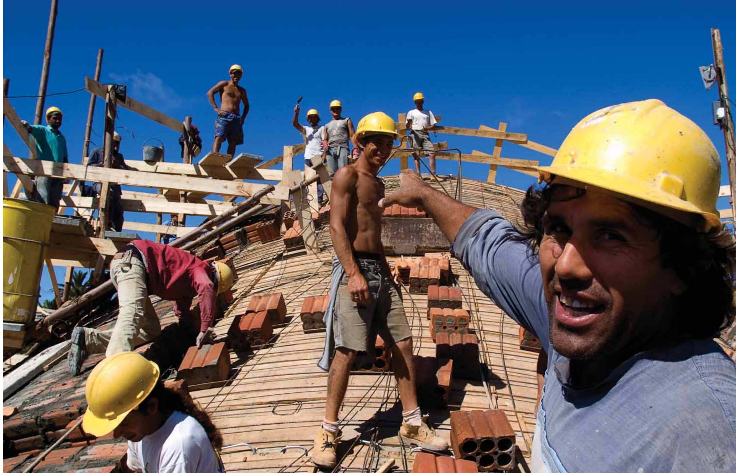
Obras de construcción de la nueva boveda del Teatro de Verano "Ramón Collazo". 6 de diciembre de 2006. (Foto: 20064FMCMA.CMDF.IMM.UY - Autor: Carlos Contrera/CdF) Trabalhos de construção da nova abóbada do Teatro de Verão "Ramón Collazo". 6 de dezembro de 2006. (Foto: 20064FMCMA.CMDF.IMM.UY - Autor: Carlos Contrera/CdF) Building works of the new vault, Summer Theatre "Ramón Collazo". December 6, 2006. (Photo number: 20064FMCMA.CMDF.IMM.UY - Author: Carlos Contrera/CdF)
