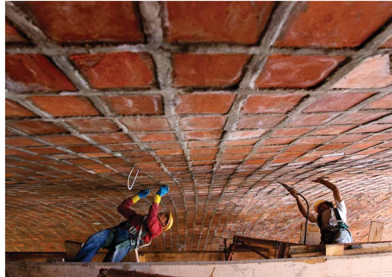
Obras de construcción de la nueva bóveda del Teatro de Verano "Ramón Collazo". 19 de diciembre de 2006. (Foto: 20079FMCMA.CMDF.IMM.UY - Autor: Carlos Contrera/CdF) Trabalhos de construção da nova abóbada do Teatro de Verão "Ramón Collazo". 19 de dezembro de 2006. (Foto: 20079FMCMA.CMDF.IMM.UY - Autor: Carlos Contrera/CdF) Building works of the new vault, Summer Theatre "Ramón Collazo". December 19, 2006. (Photo number: 20079FMCMA.CMDF.IMM.UY - Autor: Carlos Contrera/CdF)
