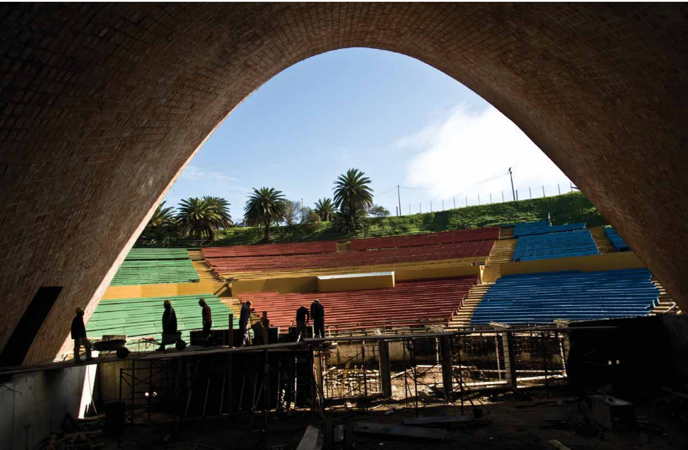
Obras de construcción del bajo escenario técnico del Teatro de Verano "Ramón Collazo". 3 de setiembre de 2009. (Foto: 17711FPMCMA.CMDF.IMM.UY - Autor: Carlos Contrera/CdF) Trabalhos de construção do espaço técnico no cenário do Teatro de Verão "Ramón Collazo". 3 de setembro de 2009. (Foto: 17711FPMCMA.CMDF.IMM.UY - Autor: Carlos Contrera/CdF) Building works of the technical stage wing, Summer Theatre "Ramón Collazo". September 3, 2009. (Photo number: 17711FPMCMA.CMDF.IMM.UY - Author: Carlos Contrera/CdF)
