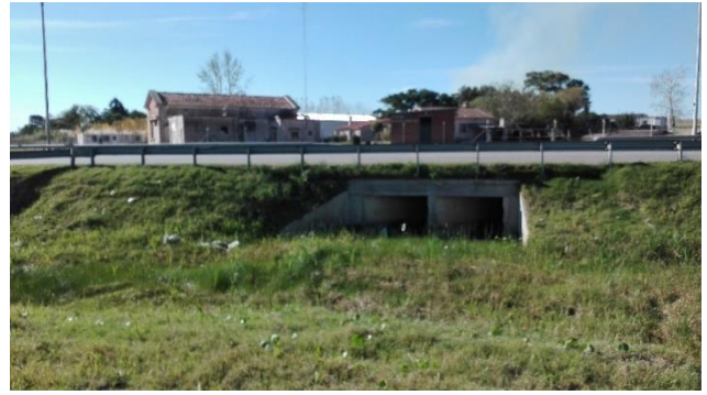
Alcantarilla por debajo de Ruta N°102
