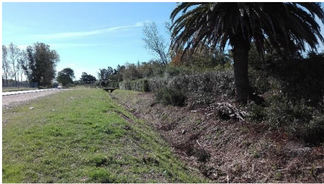
Cuneta camino Melilla Este
