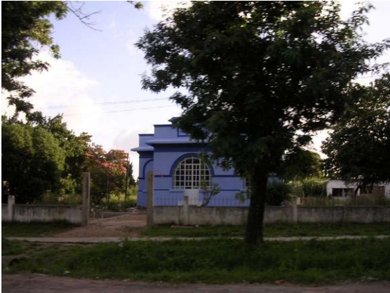
UP1- Paso de la Arena
