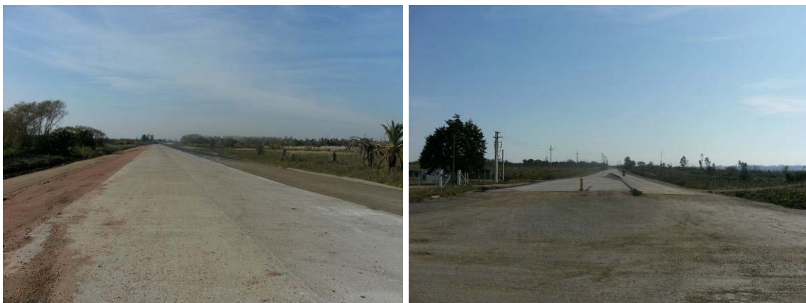
Vistas Ruta nacional N° 102 / Colector vial perimetral
