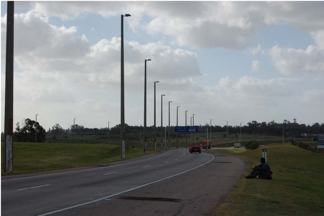
Conectividad nacional / Vista al norte de Ruta N° 5.
