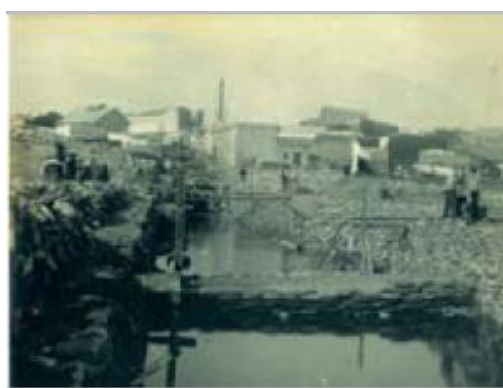
Figura 3.2. Desembocadura del Colector. [1903-1906].
