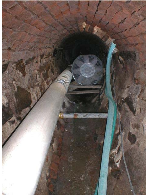
Ilustración 2: Colector de Artega típico en proceso de rehabilitación por la Intendencia de Montevideo (aprox. 2007).
